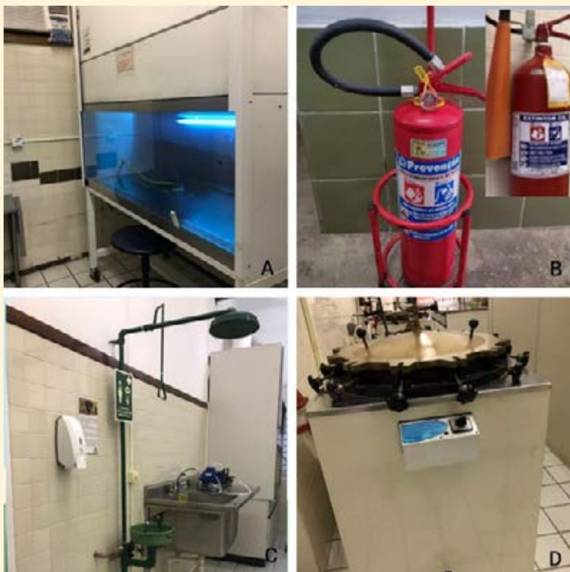
Figura 6 – Equipamentos de Proteção Coletiva (EPC's) - A: Cabine de fluxo laminar; B: Extintor de incêndio; C: Chuveiro de emergência e lava-olhos; D: Autoclave. Fonte: (Arquivo Próprio)
