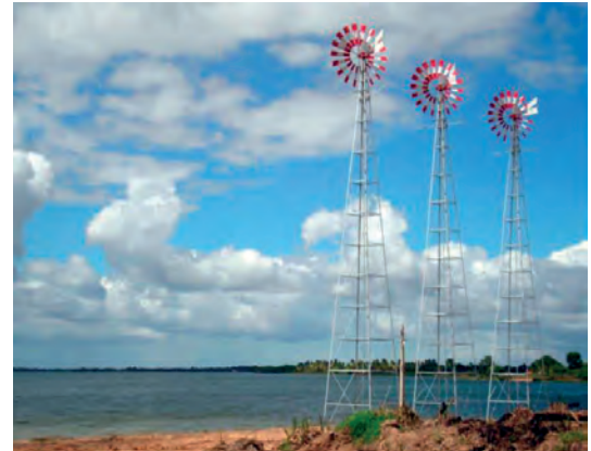
Figura 2.28 – À esquerda caixa d'água com placas de energia solar no topo; o poço se encontra por trás da caixa d'água sendo bombeado com a energia das placas; à direita um cata-vento que usa a energia eólica para captação por pistoneamento da água do poço.
