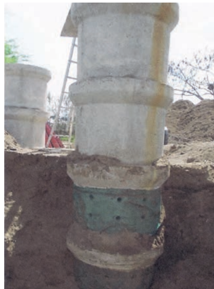
Figura 2.24 – Acima poço amazonas construído com tijolos e argamassa e revestido com tela de nylon; ao lado poço amazonas construído com anéis de concreto previamente perfurados e revestidos com tela de nylon.
