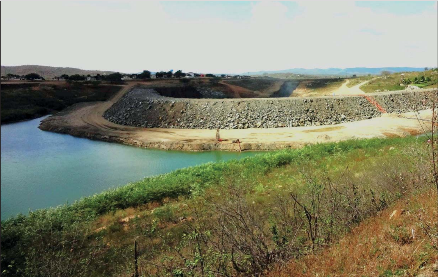
Figura 7 - Ensecadeira construída para permitir a escavação do Canal de Aproximação da Barragem de Captação.
