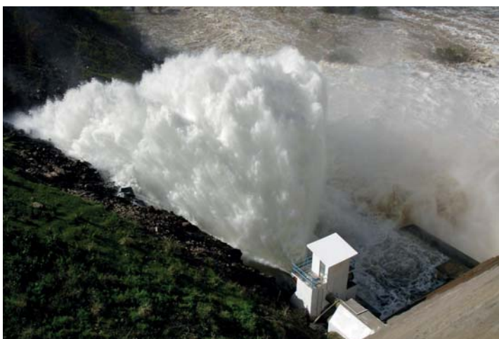
Figura 5 - Válvula Dispensora aberta da Barragem de Acauã.
