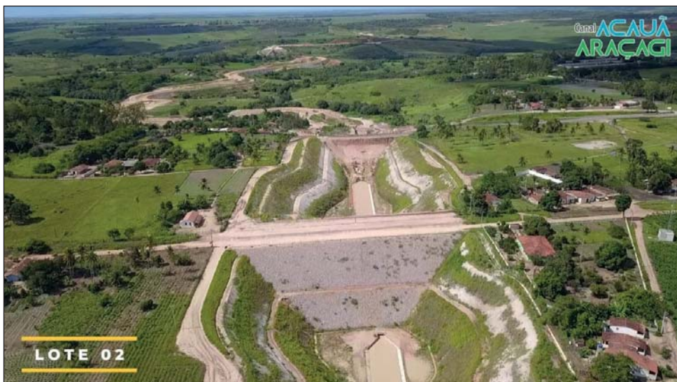
Figura 16 - Travessia por estrada secundária, mostrando a grande altura do corte e dos aspectos de proteção de talude.
