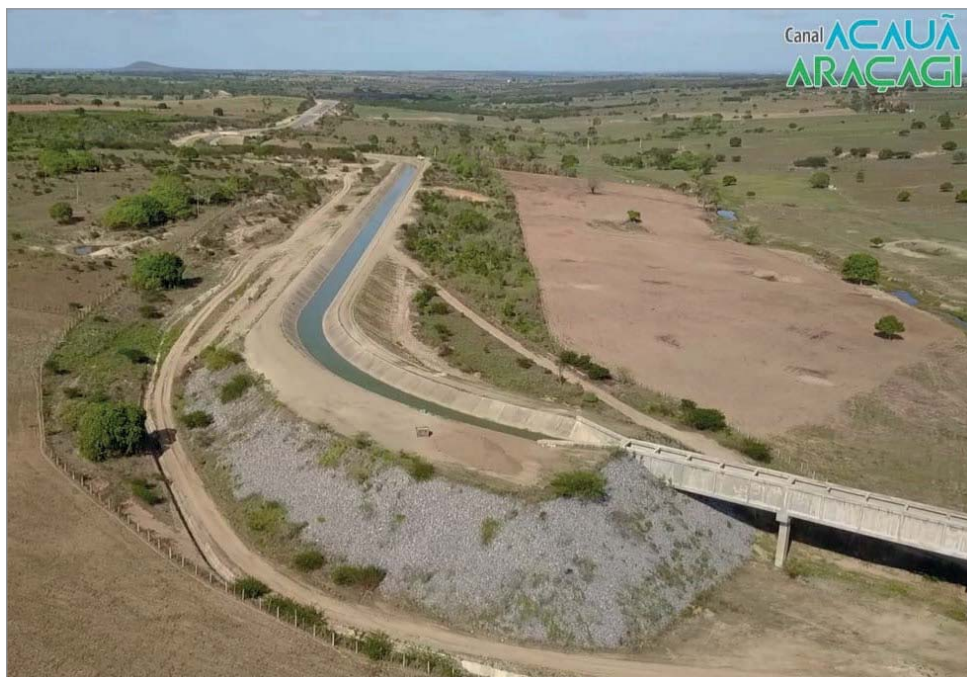
Figura 21 - Vista aérea da ligação do aqueduto com canal.
