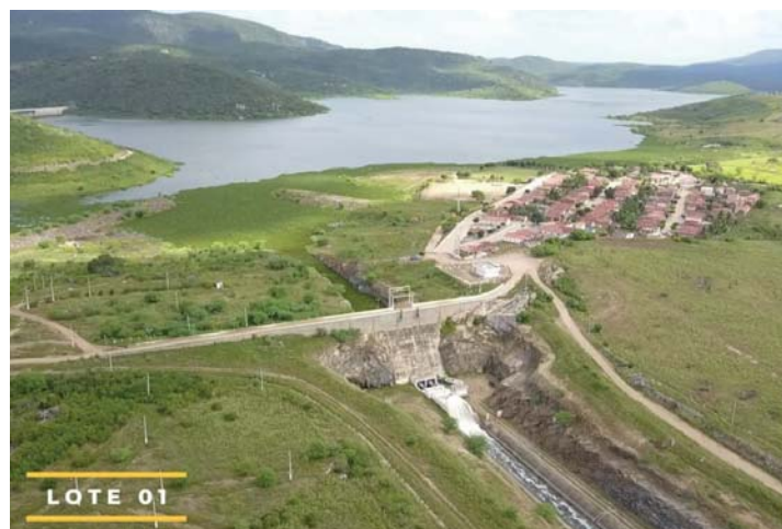
Figura 6 - Barragem de Captação, mostrando também o canal de aproximação e o início do Canal Acauã-Araçagi; ao fundo vê-se a Barragem de Acauã.
