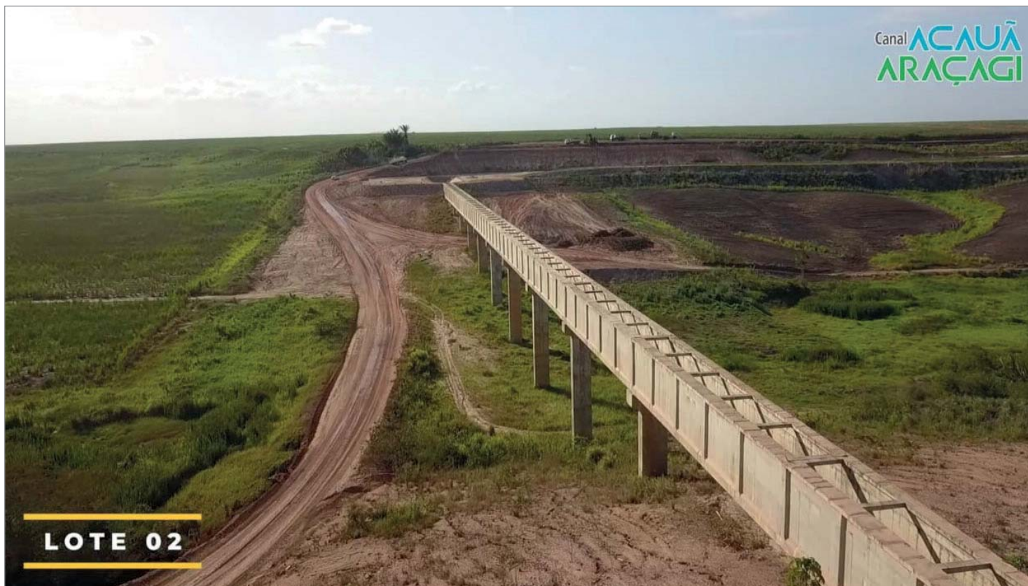
Figura 20 - Vista aérea de Aqueduto
