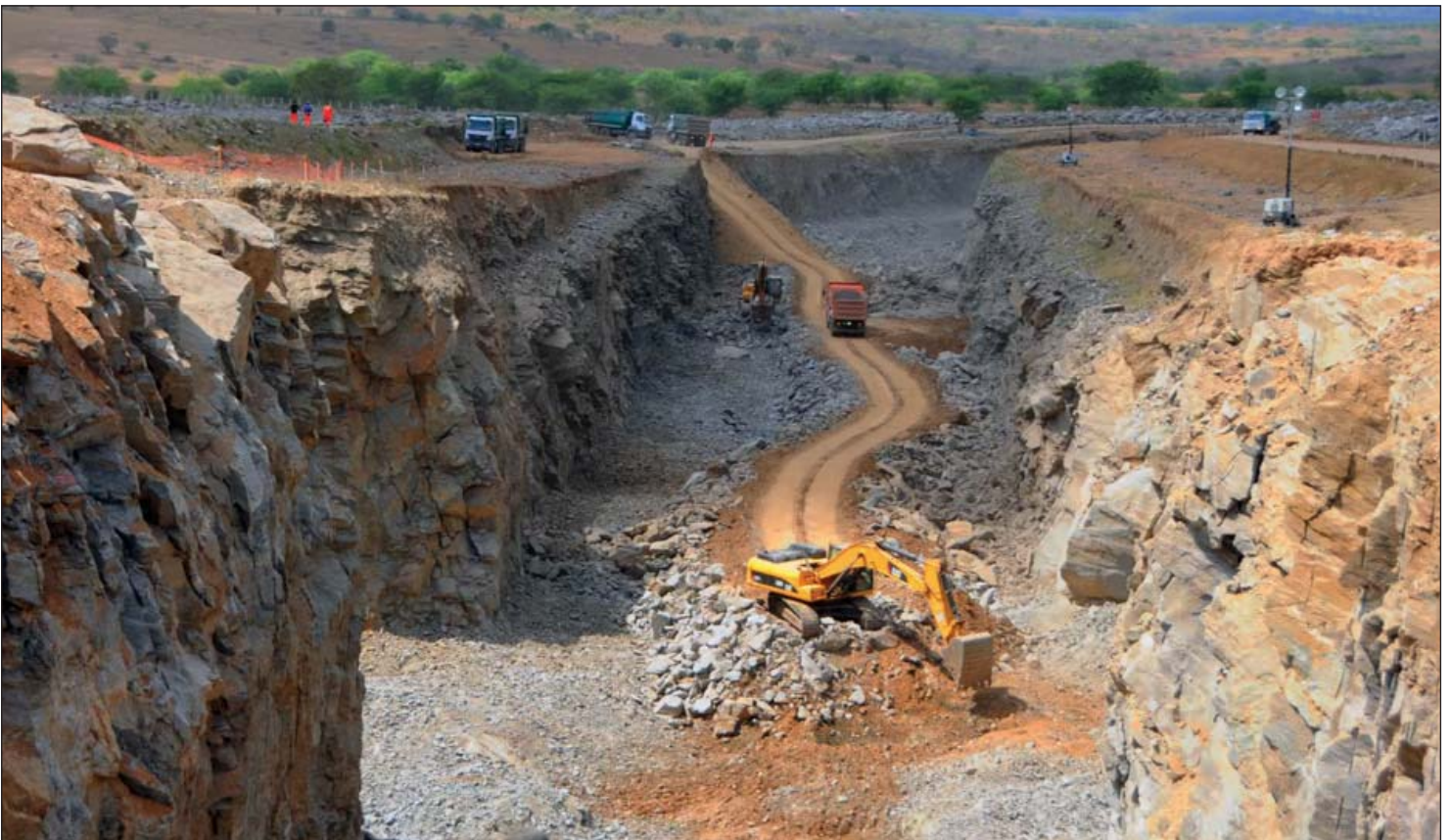
Figura 8 - Escavação em rochas na barragem de captação.
