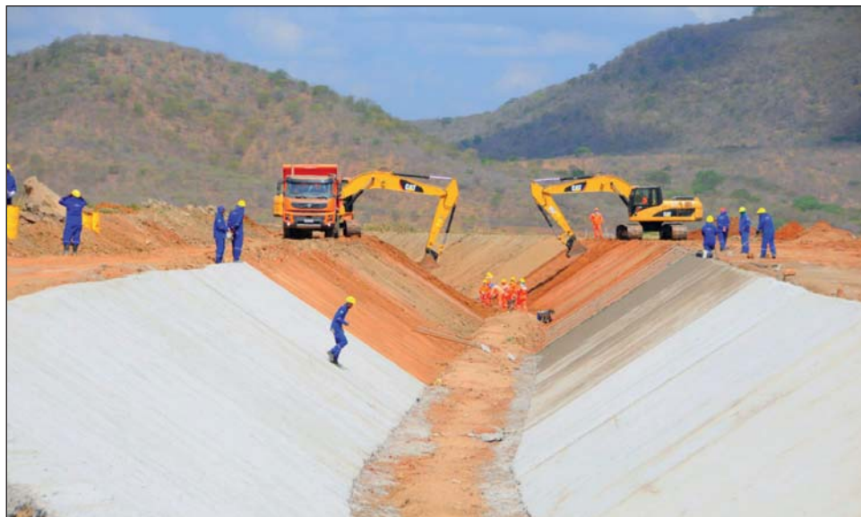
Figura 12 - Trecho do Canal em Construção.
