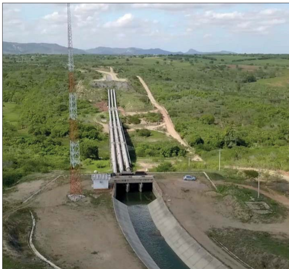
Figura 14 - Detalhe do Sifão Mogeiro com a estrutura de transição concluída.
