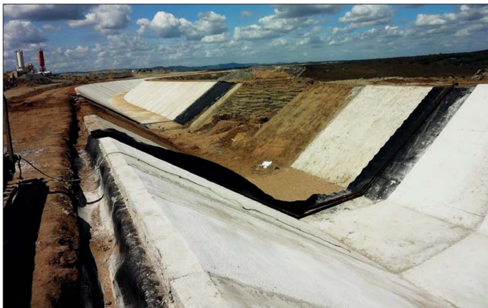
Figura 13 - Detalhe do Canal em construção vindo-se do lado esquerdo uma vala para fixação do revestimento de polietileno de alta densidade, PEAD.
