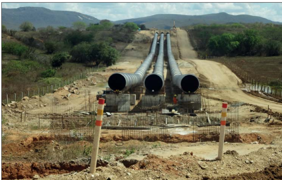
Figura 11 - Detalhe da construção do Sifão Mogeiro com três linhas de aço no diâmetro de 1,90m cada e vazão total de 10 m 3 por segundo.
