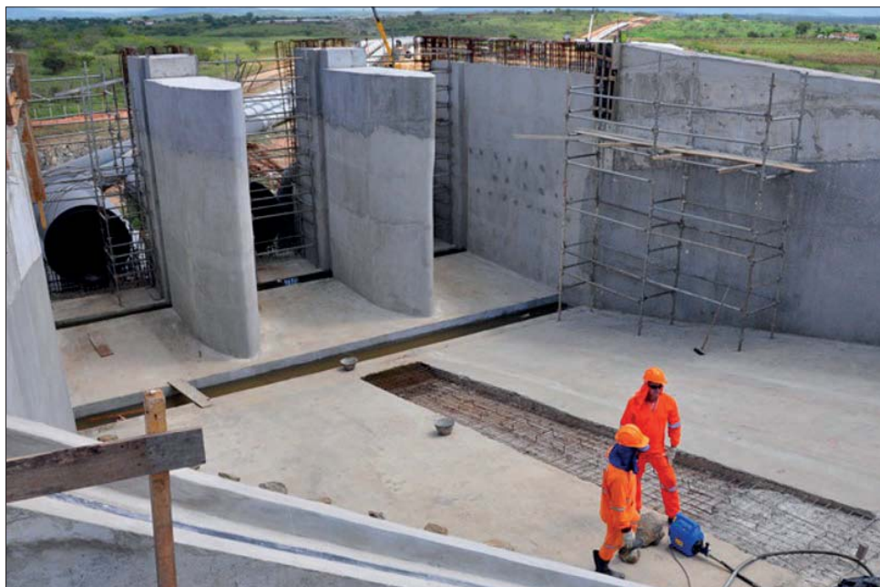
Figura 9 - Detalhe da estrutura de ligação do Canal Acauã com o Sifão Mogeiro.
