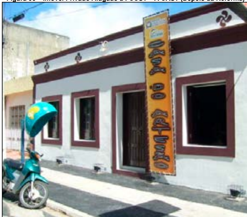
Figura 06 – Imóvel Privado Alugado à FCCST – A CAST (Depois da Reforma)
