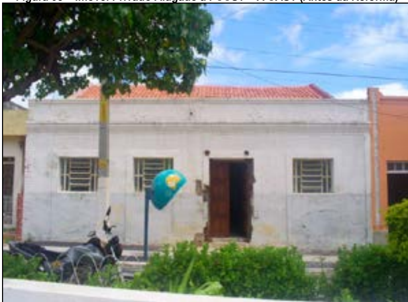
Figura 05 – Imóvel Privado Alugado à FCCST – A CAST (Antes da Reforma)
