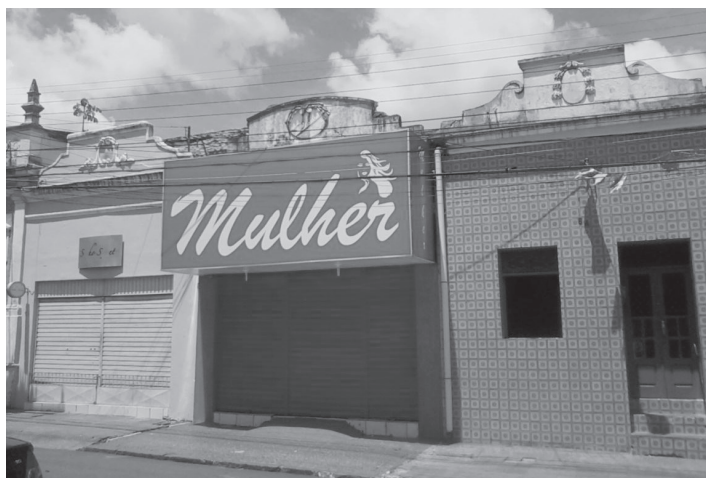
Figura 2: Edificações dos números 64, 68 e 72 da Rua Vigário João Batista, Centro do Cabo. Fonte: autor, 2018.
