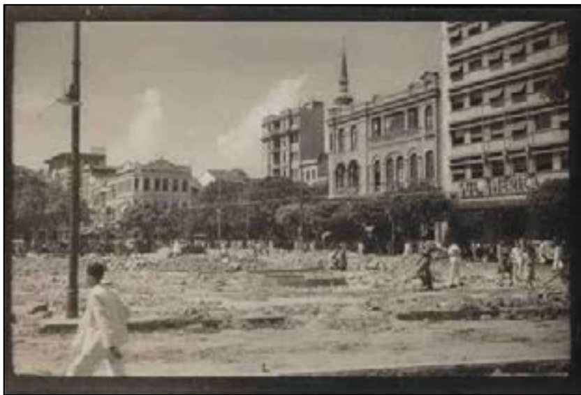
Figura 3 - Demolição da Praça da Independência para abertura da avenida Dantas Barreto. Registro por Benício Dias, em 1945.
