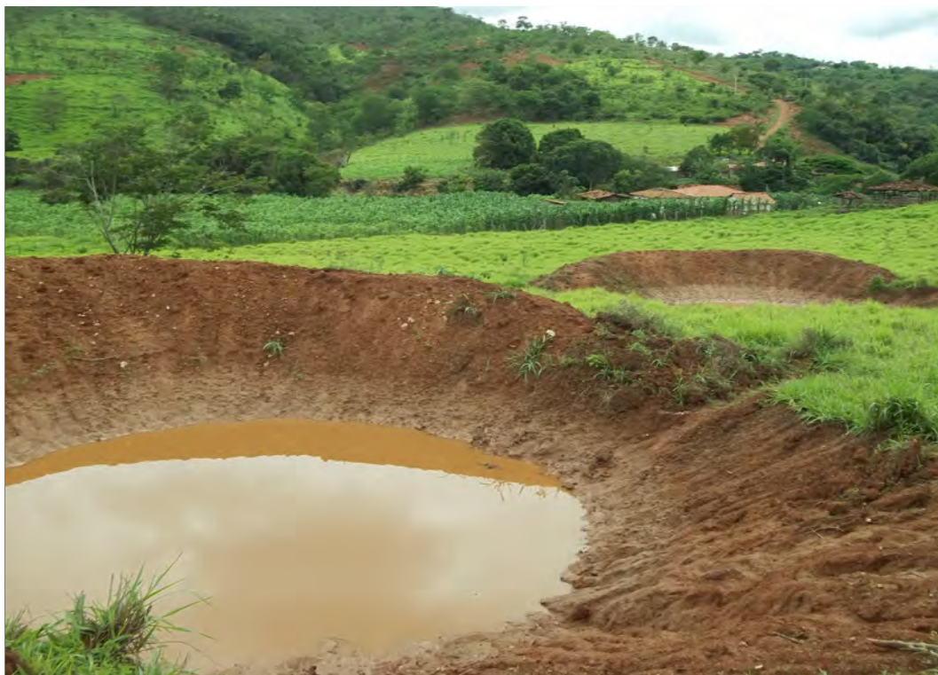
Barraginhas construídas no semiárido, em Minas Novas, MG. (Foto: Luciano Cordoval)
